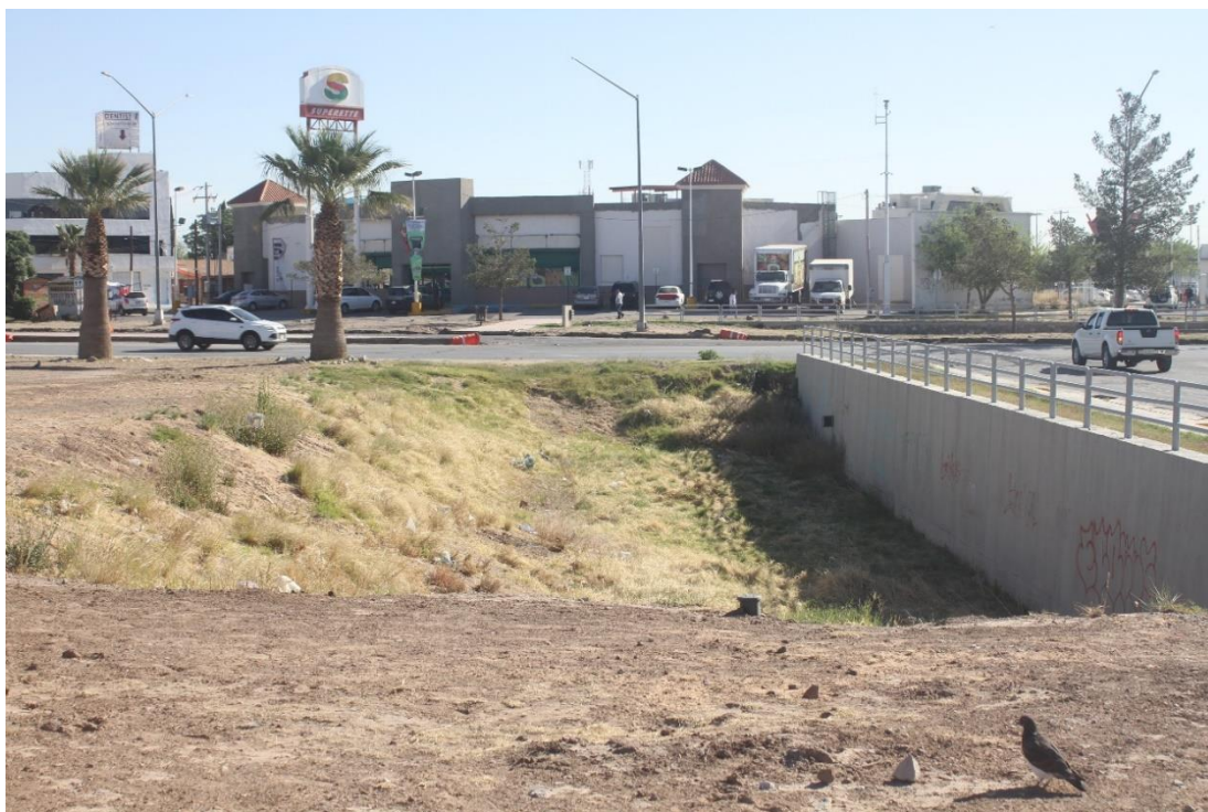
Imagen 11. Vasos de captación en la avenida Abraham Lincoln
